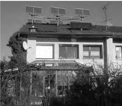
Ein besonderes Reihenhaus: PV-Solarzellen und Sonnenkollektoren (für heißes Wasser) auf dem Dach, die Wände dick isoliert und davor der Wintergarten (Foto: K. Schweim)
